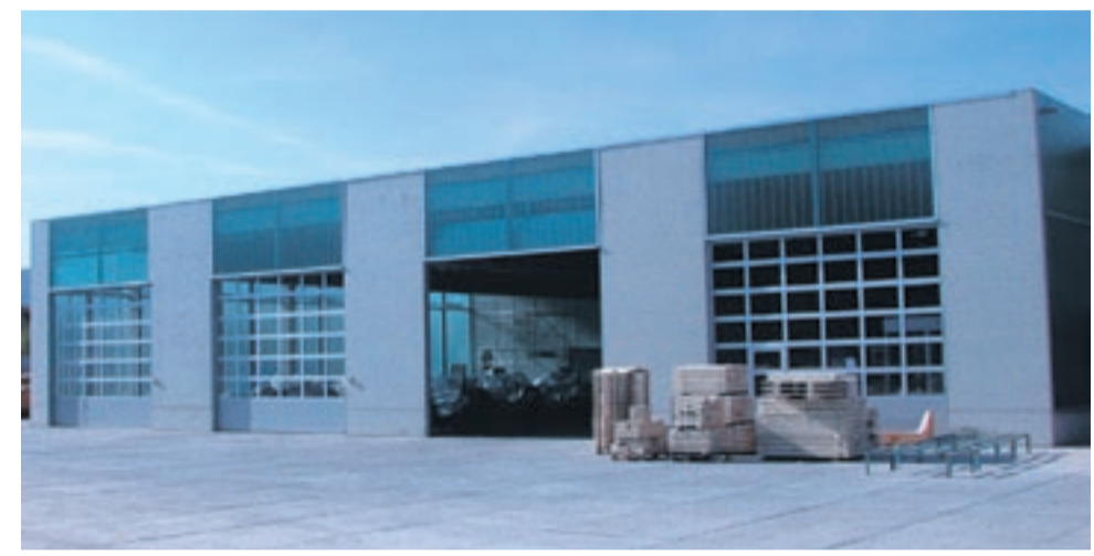
Die Wartezeit der Spediteure deutlich verkürzen: Die im ersten Bauabschnitt entstandene Auslieferungshalle. Fotos: Otto MARTIN
